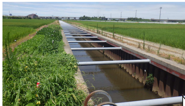
鋼矢板護岸の農業用排水路
