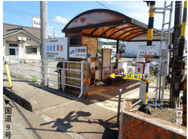
写真 4.8 仁保津駅における浸水の痕跡
