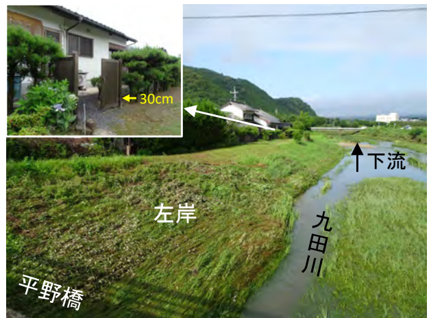
写真 1.3 平野橋下流の左岸における九田川の水位と宅地の浸水状況（2日撮影）
