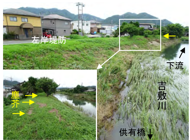
写真 2.11 吉敷川に架かる供有橋の下流の左岸堤防における塵芥の状況（3日撮影）
