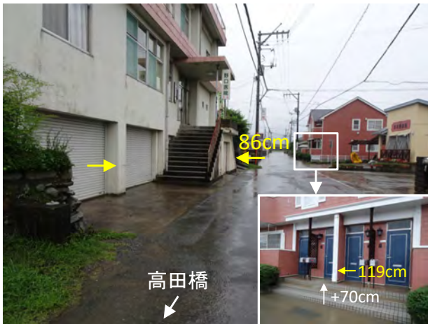
写真 2.5 岩富に位置する医院と集合住宅における浸水の状況 (1日 7時 30分撮影)
