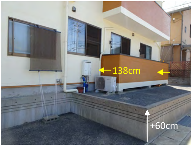
写真 4.4 店舗兼住宅における浸水痕跡
