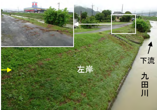
写真 1.2 広瀬橋下流左岸における九田川の水位と塵芥の状況（1日11時11分撮影）
