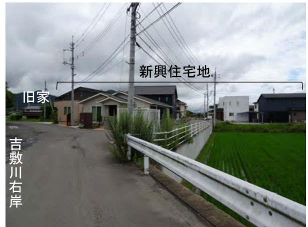
写真 2.18 吉敷川の大歳橋下流右岸において 開発された新しい住宅地 (3 日撮影)
