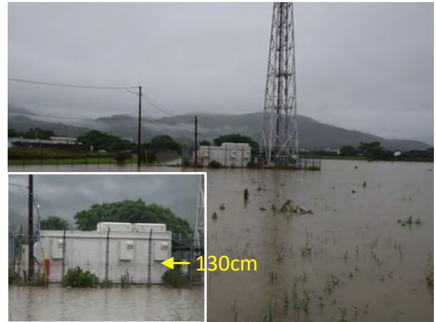
写真 2.2 岩富における NTT ドコモ山口朝田基地局の浸水状況（1日7時38分撮影）
