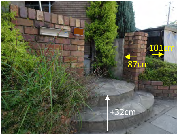
写真 4.5 床上浸水した住宅の浸水痕跡
