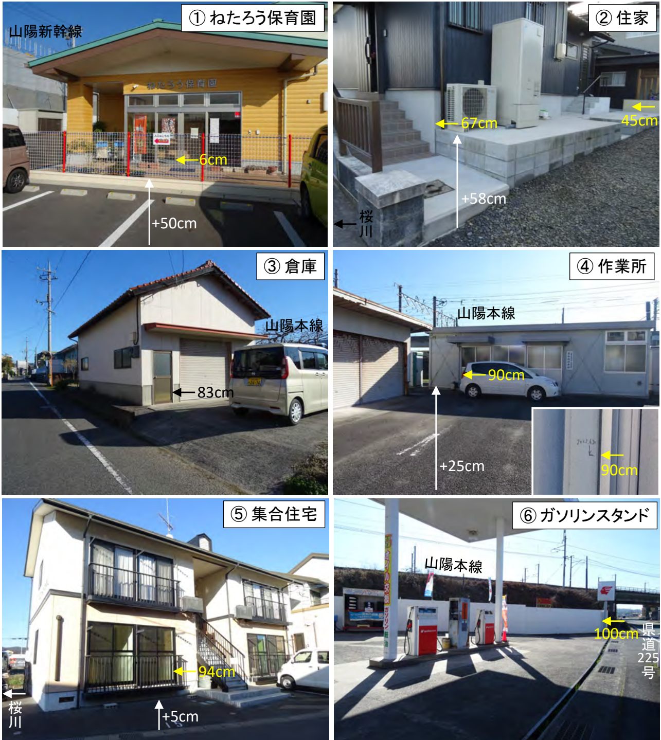
写真 6 2023 年水害による厚狭地区の浸水被害（①～⑥は図 14 と一致）
