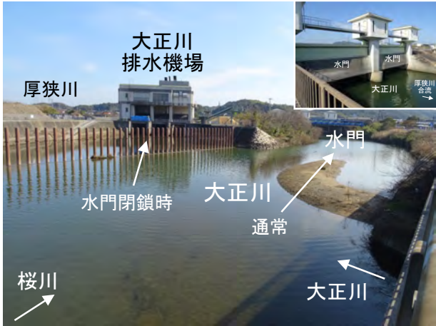
写真5 大正川排水機場・水門 (2023年8月10日撮影)
