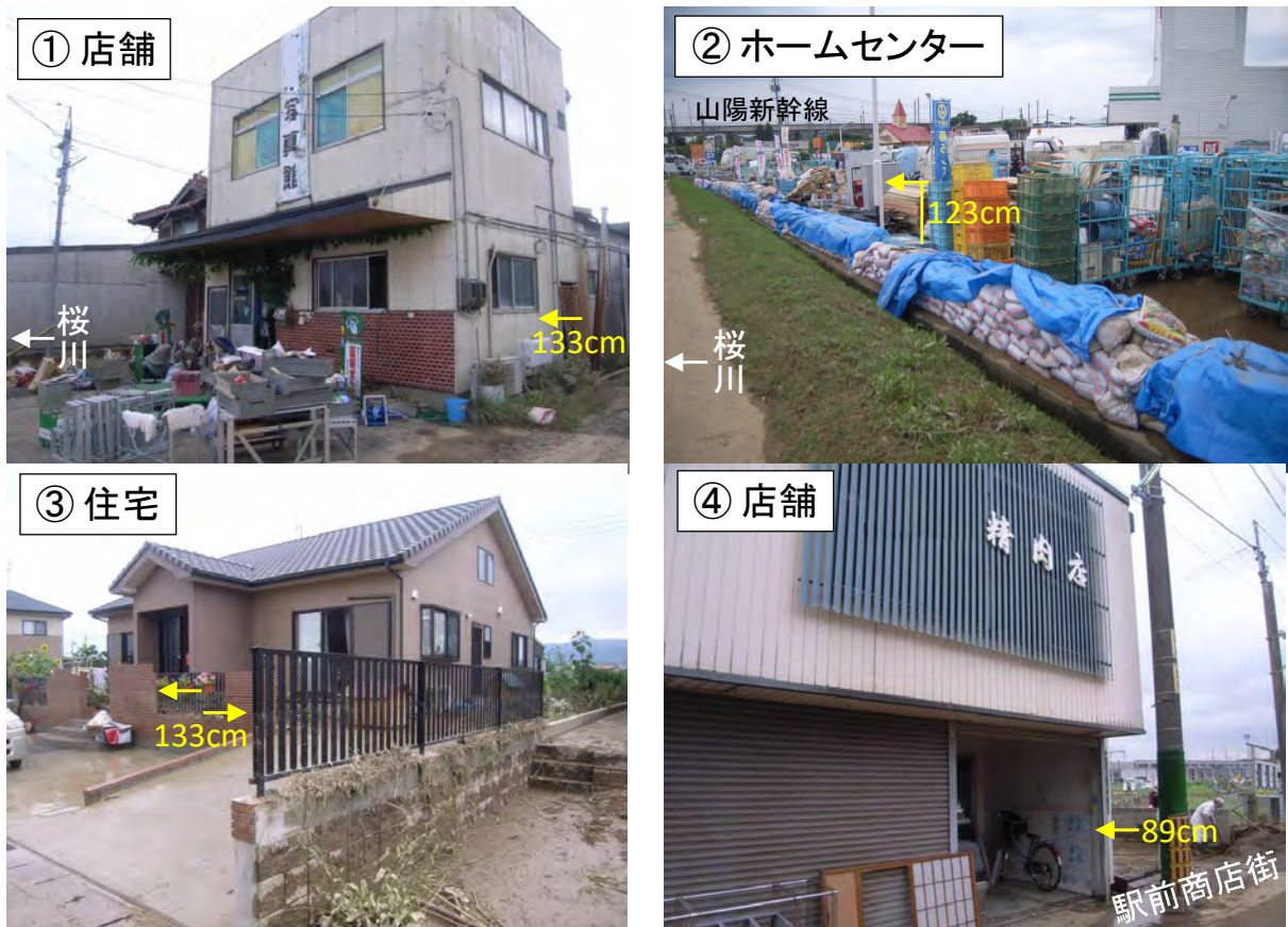
写真3 2010年水害による厚狭地区の浸水被害 (①~④の位置は図9に示す。山崎ら、2010) (浸水深 (cm) は地盤からの高さを示す)
