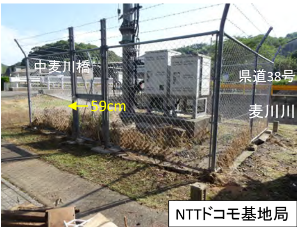
写真 2.3 NTT ドコモの美祢下麦川基地局における浸水の痕跡（地盤からの高さ、cm）
