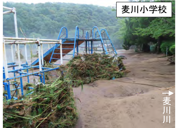
写真 2.8 麦川小学校における運動場の浸水被害 (美祢市立麦川小学校、2023b)
