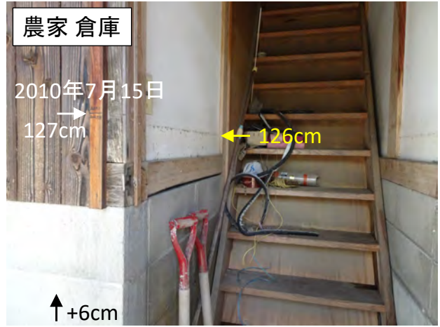
写真 5.14 農家の倉庫における 2010 年と 2023 年における浸水の痕跡（地盤からの高さ、cm）
