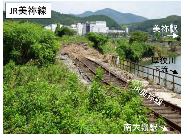
写真 3.1 美祢線における路盤への塵芥の流入（美祢駅-南大嶺駅間）
