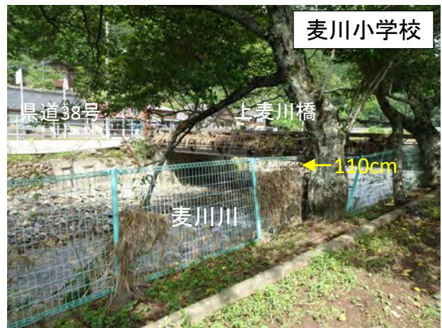
写真 2.5 麦川小学校の麦川川に面したフェンスにおける塵芥の付着(地盤からの高さ110cm)
