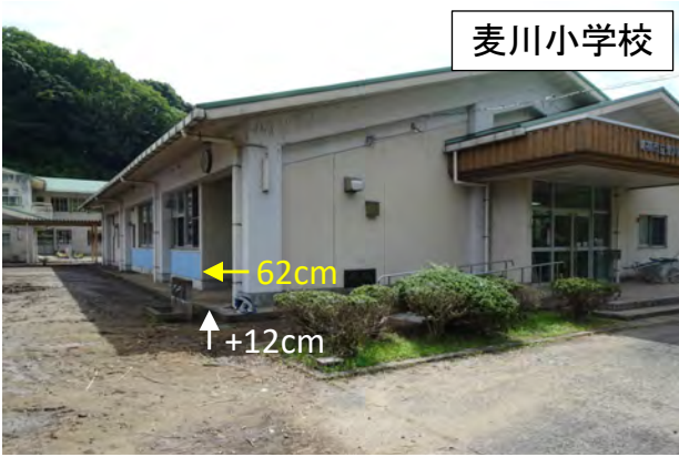
写真 2.6 麦川小学校の校舎における浸水の痕跡 (地盤からの高さ、cm)
