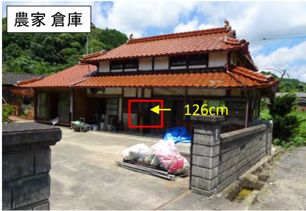
写真 5.13 農家の倉庫における浸水の痕跡（地盤からの高さ、cm）（赤枠は写真 5.14）
