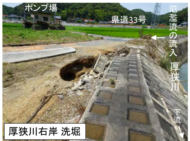
写真 4.2 厚狭川右岸における堤防裏尻の洗掘被害
