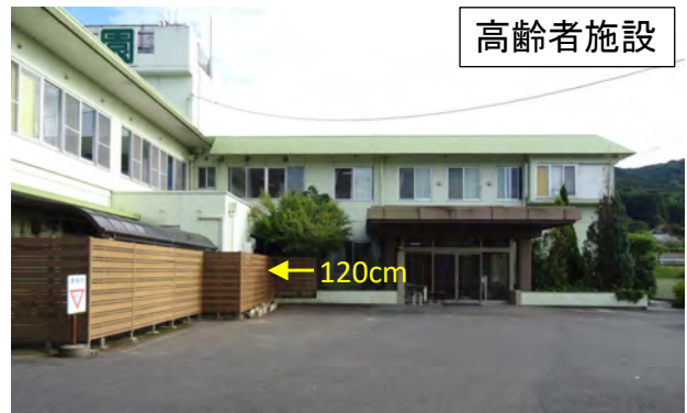
写真1.4 高齢者施設（養護老人ホーム）における浸水の痕跡（地盤からの高さ、cm）
