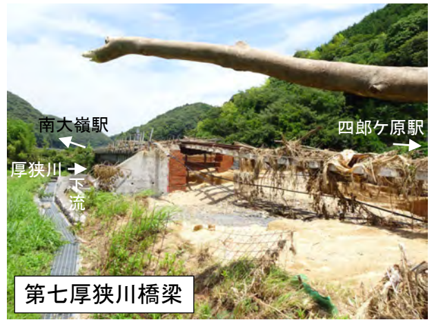
写真 4.1 JR 美祢線の第七厚狭川橋梁における盛土の流失被害
