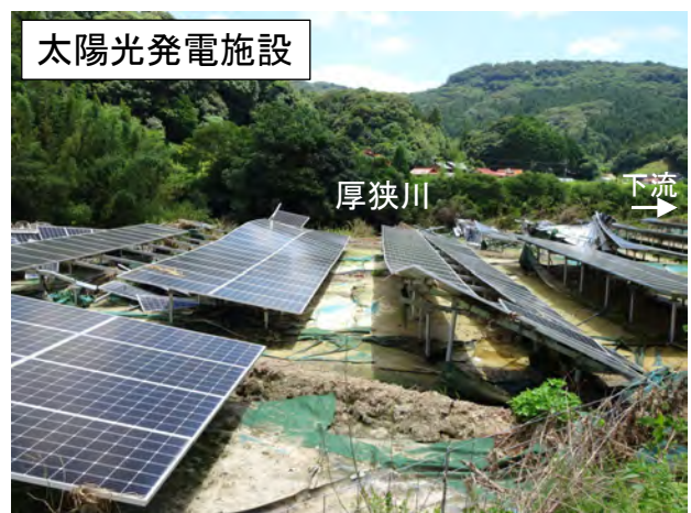
写真 5.18 太陽光発電施設における浸水被害
