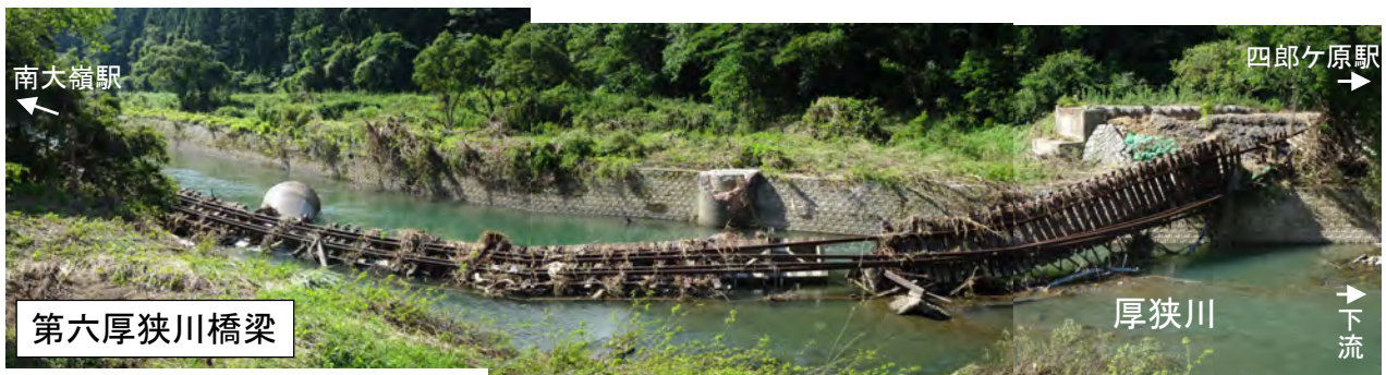
写真 4.8 JR 美祢線における第六厚狭川橋梁の流失被害（南大嶺駅—四郎ヶ原駅間）
