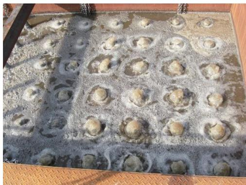
液膜式曝気装置の稼働時の様子
