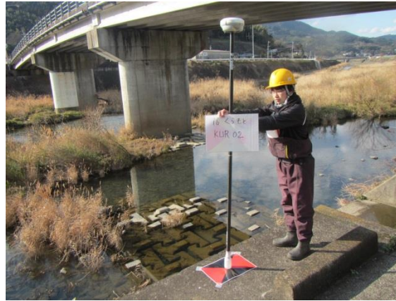
対空標識の設置と測量
