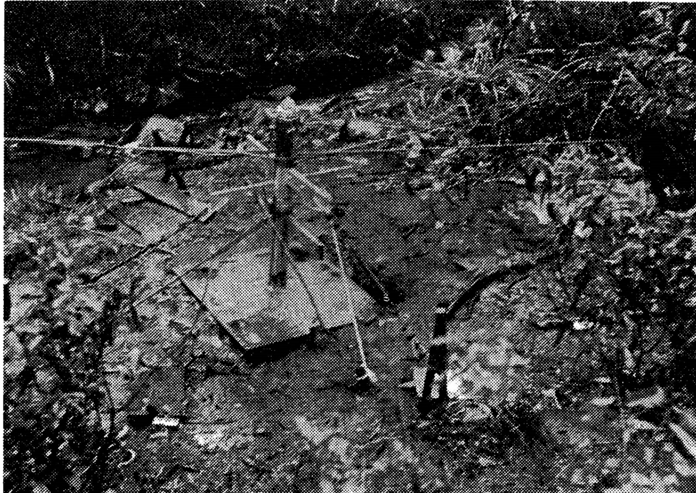
S P I V ・装薬量 3 0 0 kg の発破孔の防備状況
