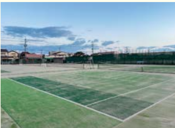
桃山グラウンドのテニスコートの補修を行いました
