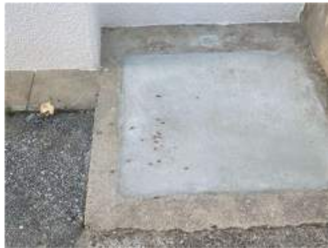
工事終了後、再開されたエサの放置
