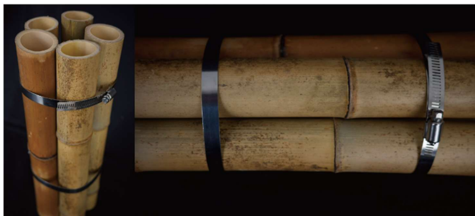
図 09 竹を建築用のステンレスバンドを用いて緊結した
