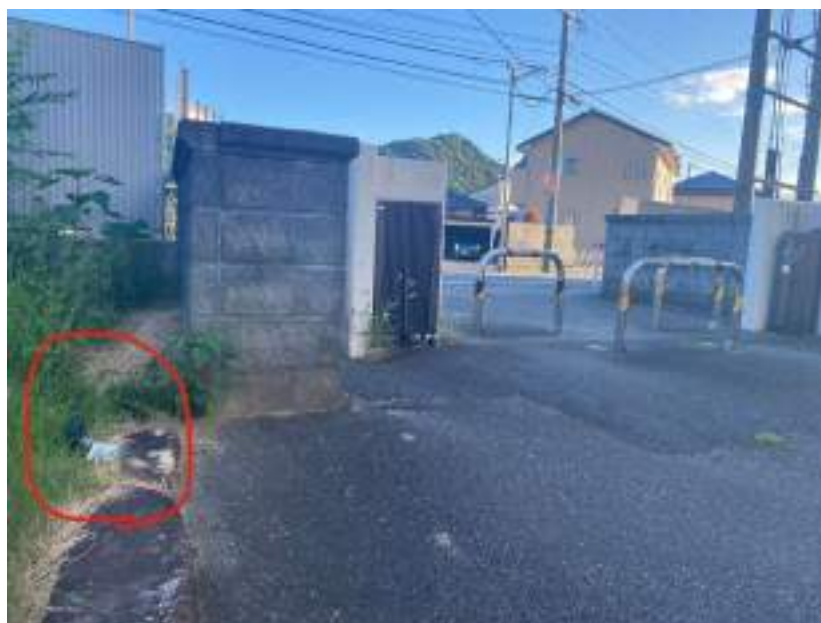
国際交流会館付近における超音波装置の設置
