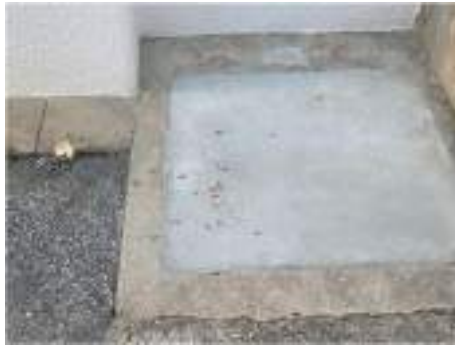
工事終了後、再開されたエサの放置
