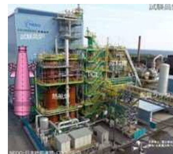
COURSE50試験高炉
